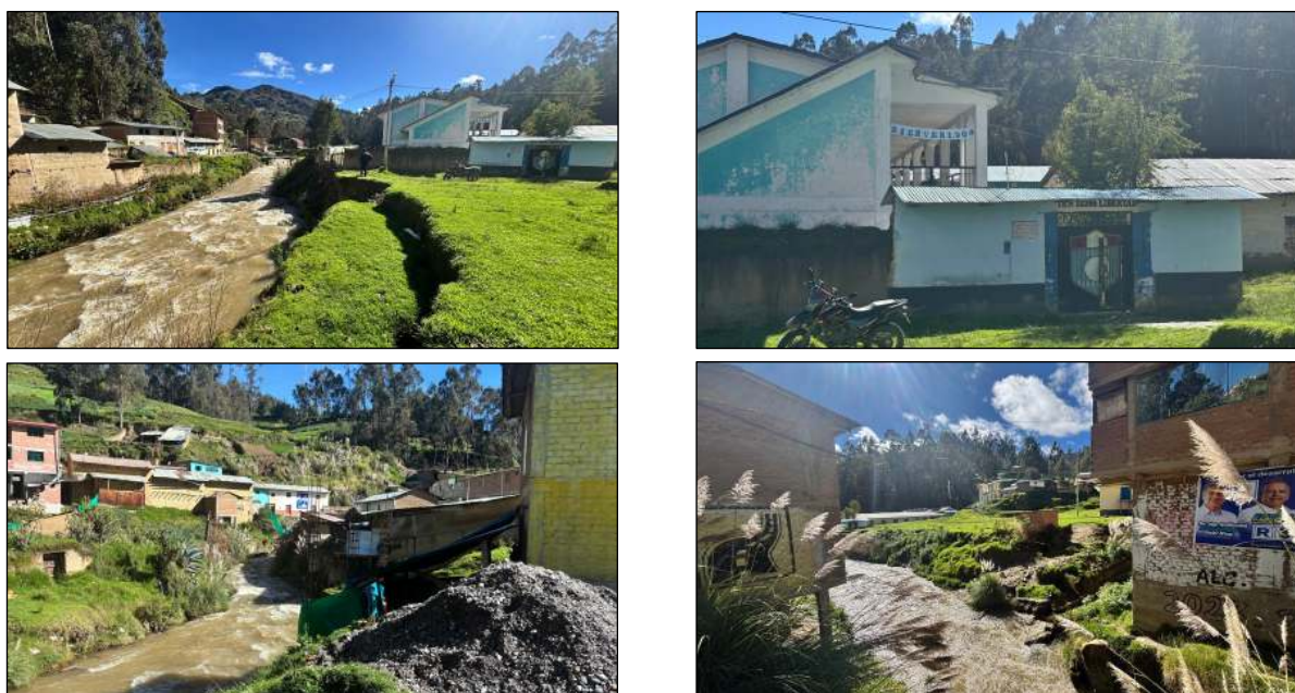
Figura N° 01. Se muestra la erosión en la margen derecha del río Libertad, afectando el muro de contención de la institución educativa y poniendo en riesgo la infraestructura y viviendas cercanas.
